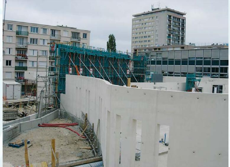
Adaptation spécifique avec coffrage métallique pour caniveau de bassin en station d'épuration.
