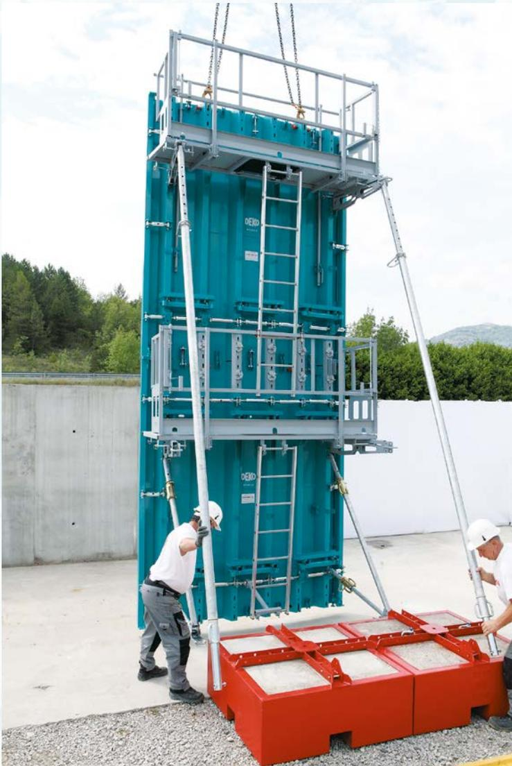
Les chapes de réhausse assurent la rigidité et la verticalité de l'ensemble lors des opérations de relevage de banches superposées.
