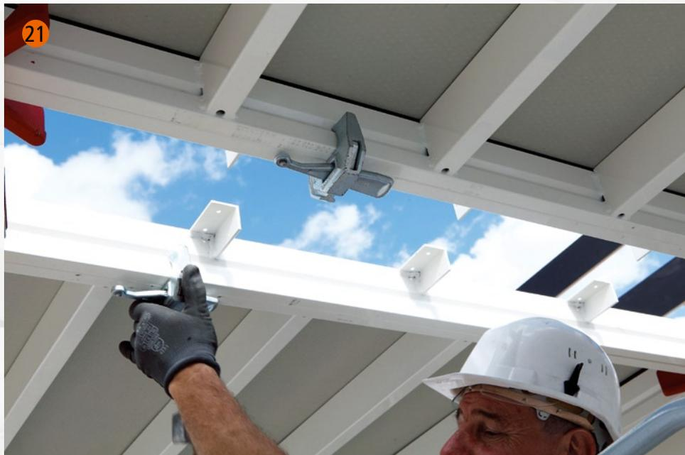
**20**, **21** Mise en place du profil de correction DUALU, et fixation de celui-ci au cadre de l'élément par l'unique serrure.
