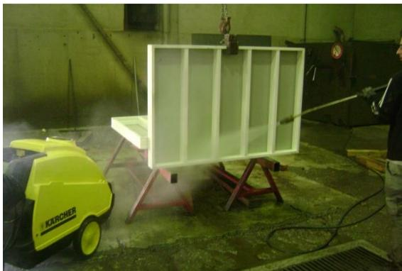
Après décoffrage nettoyer les bandes à l'aide d'un appareil haute pression ( 200 à 300 bars), et d'un grattoir.
