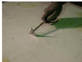
La réparation des trous ou éraflures est traitée avec un kit de réparation par soudure plastique à chaud. Se reporter à notre notice d'utilisation de ce matériel
